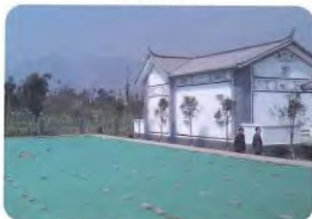
云南省洱源县葛官营村 污水处理站
