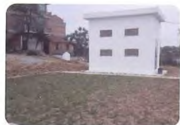
浙江省义乌市西殿村 污水处理站
