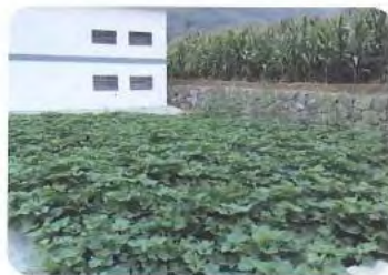
湖北省兴山县下长坪村 污水处理站
