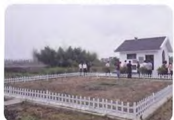
上海金山区大茫村5# 污水处理站
