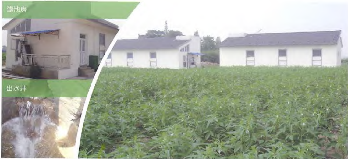
安徽芜湖大浦新农村试验区生活污水处理工程(1000m 3 /d)
